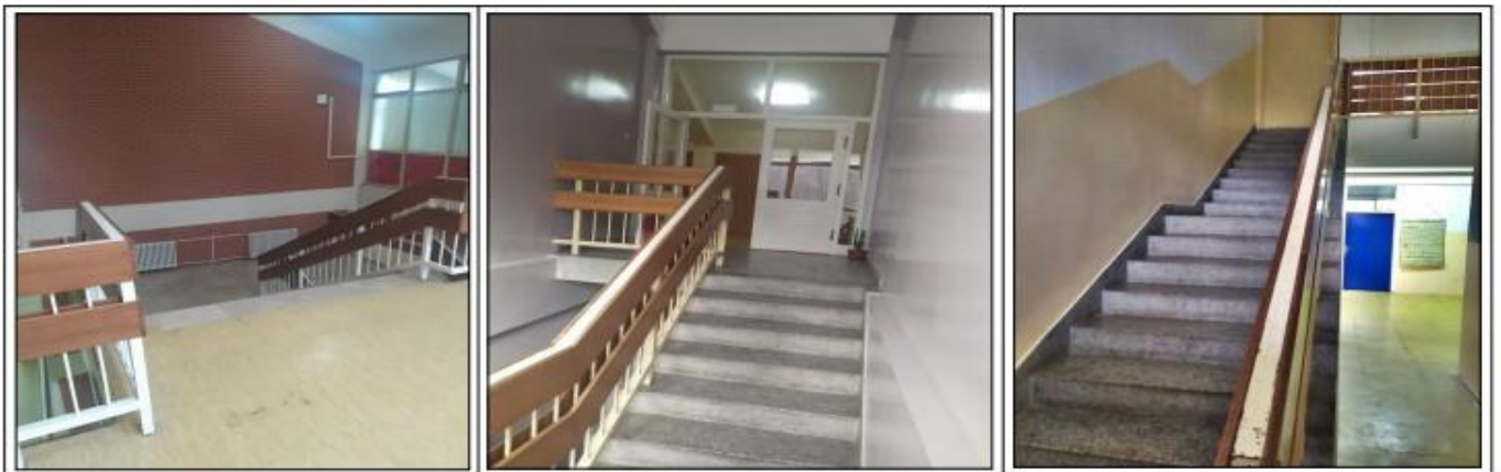
Слика 4. Степеништа у објекту
