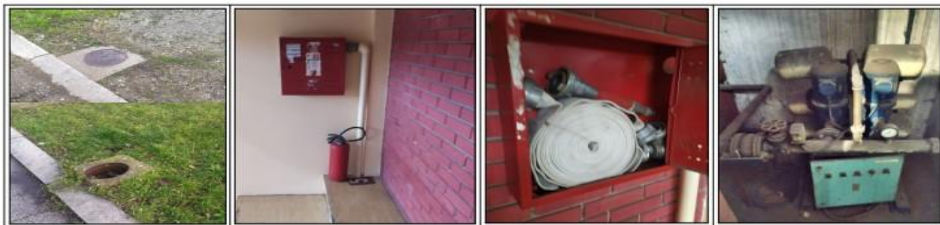
Слика 5. Подземни , зидни хидрантии хидроцил
